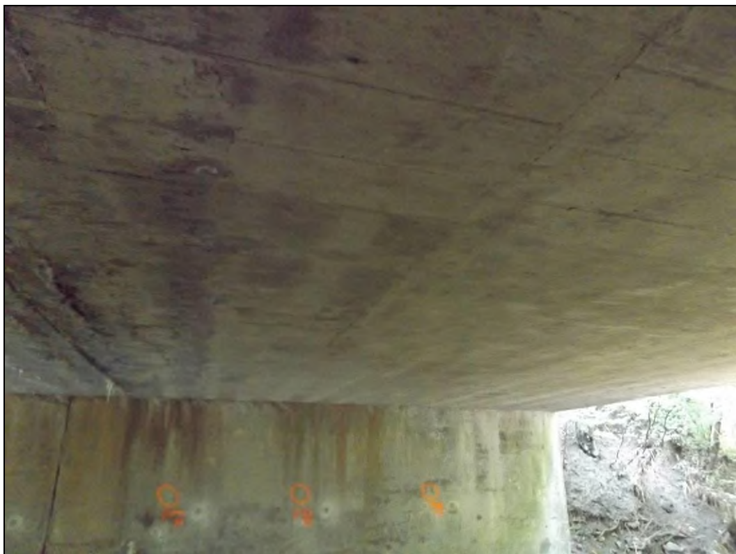
Obr. č. 10 - pohled na NK nad levou částí, většina této části je ve spodním líci bez poruch, degradace omítky ve spodním líci a průsaky jsou patrné v blízkosti DS mezi levou a střední částí
