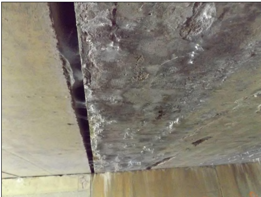
Obr. č. 12 - detailní pohled na oblast spodního líce NK nad střední částí u DS mezi střední a pravou částí.
