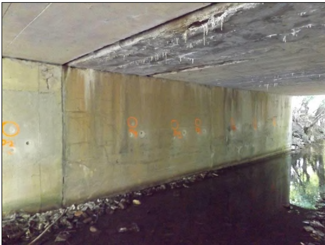
Obr. č. 9 - opěra Vsetín, střední a levá část. Zde jsou v NK nad střední částí intenzivní průsaky skrze desku NK.
