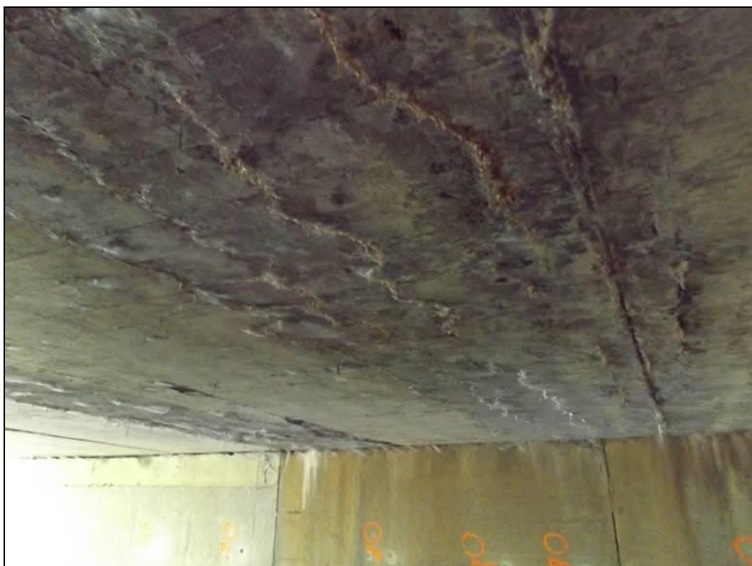
Obr. č. 11 - pohled na spodní líc NK nad střední částí, většina plochy desky je s průsaky a degradovanou omítkou na spodním líci
