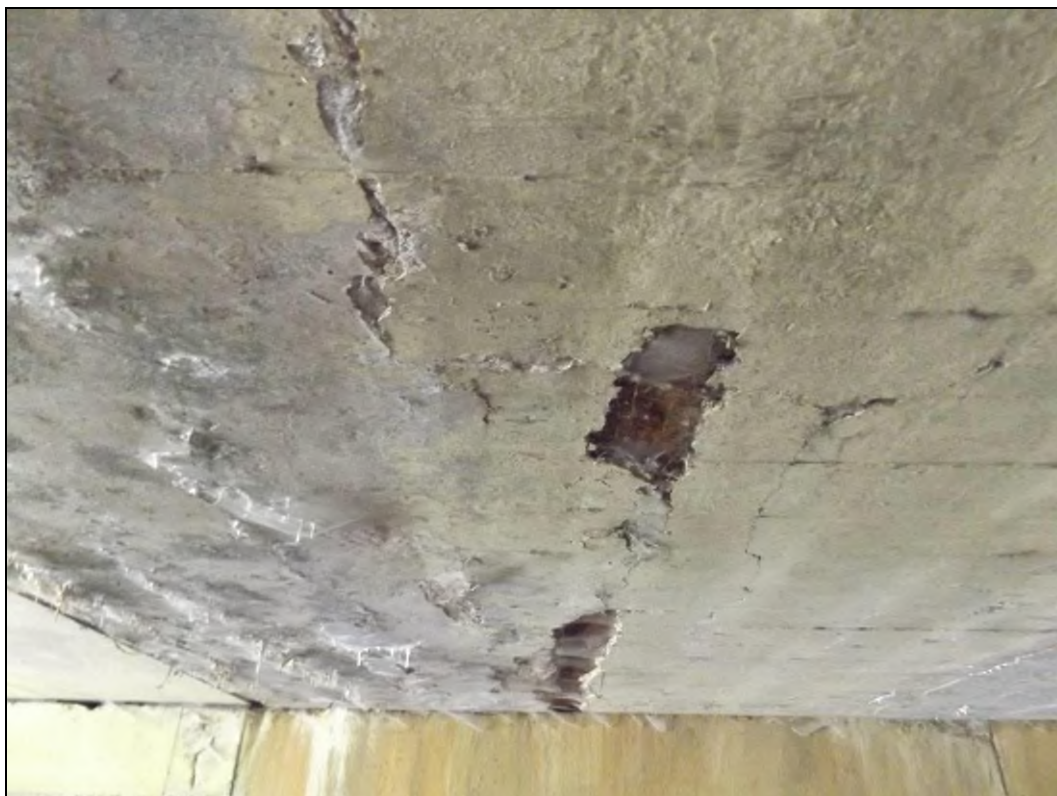
Obr. č. 14 - detailní pohled na opady omítky a odkrytou spodní pásnici zabetonovaného nosníku.
