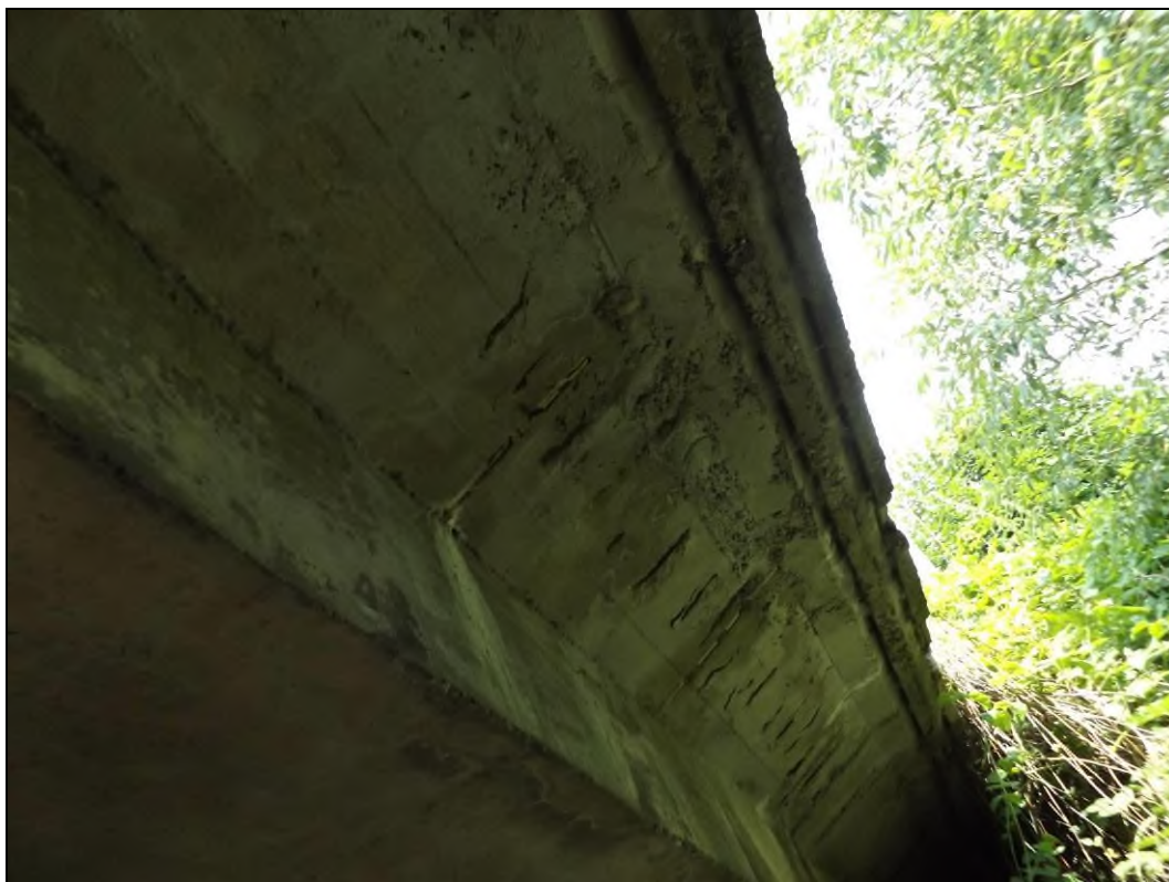
Obr. č. 16 - detailní pohled na spodní líc římsy nad pravým čelem, patrné časté opady betonu a odkrytí výztuže římsy a její koroze
