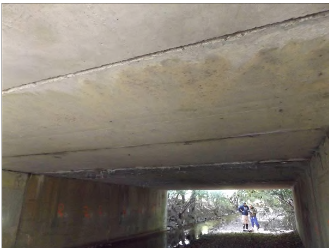
Obr. č. 13 - pohled na spodní líc nad pravou částí, spodní líc je většinou hladký a pevný
